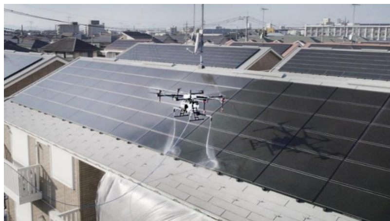
屋根部の洗浄の様子
